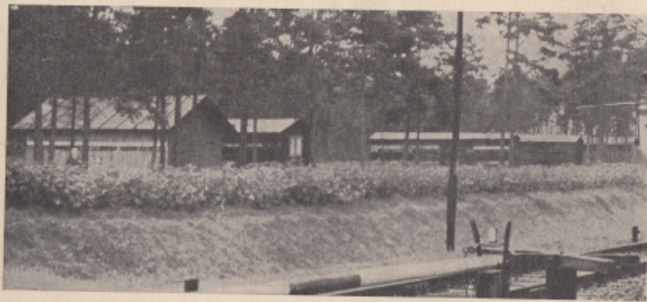
Die Wanderstände der Hersbruder Zmler in der Heide bei Altenschwand.
